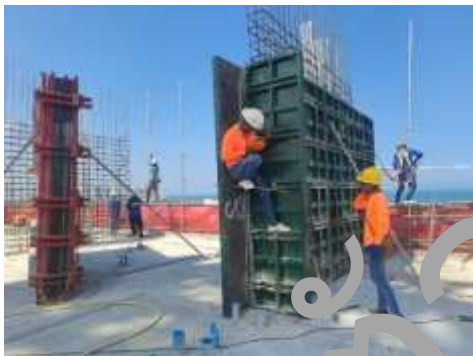
งานเทเสาคอนกรีตชั้น 1
