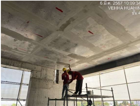
งานฉาบผิวบางลานจอดรถ ชั้น 3
