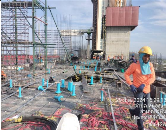
งานติดตั้ง Sleeve Pipe ห้องพัก ชั้น 12
