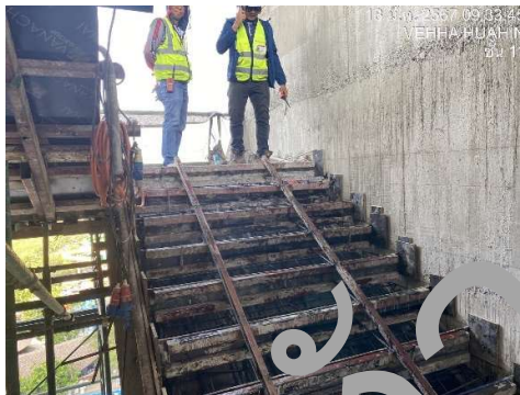
งานบันได FST-0 ชั้น 11
