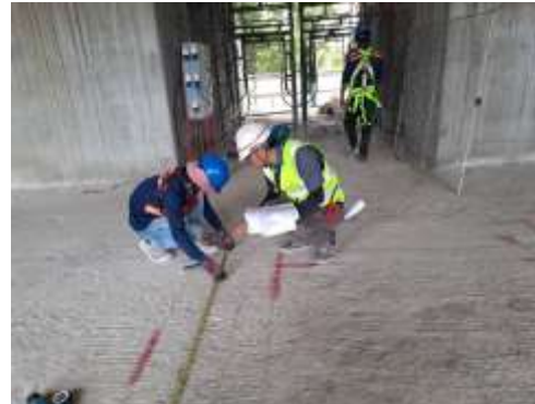
งานตรวจไลน์ก่อนเทคิบและก่ออิฐชั้น 2-3
