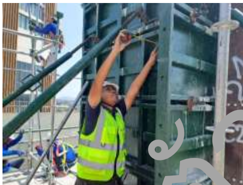
งานดิ่งเสา ชั้น 11
