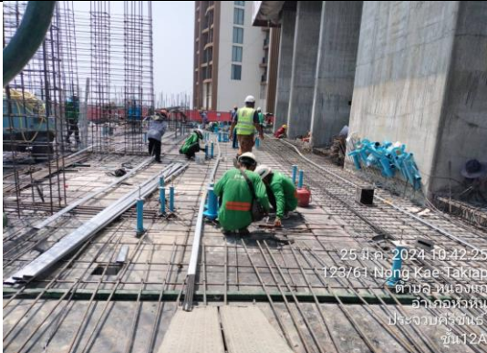
ติดตั้ง Sleeve Pipe ห้องพัก ชั้น 12
