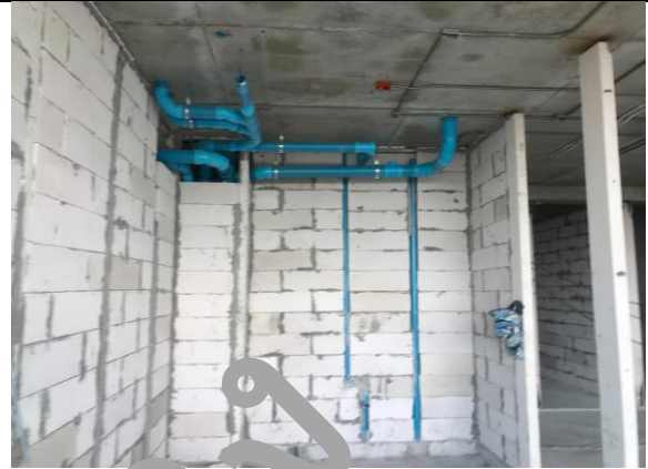
เดินท่อ W,V,KW ในผนังชั้น 8
