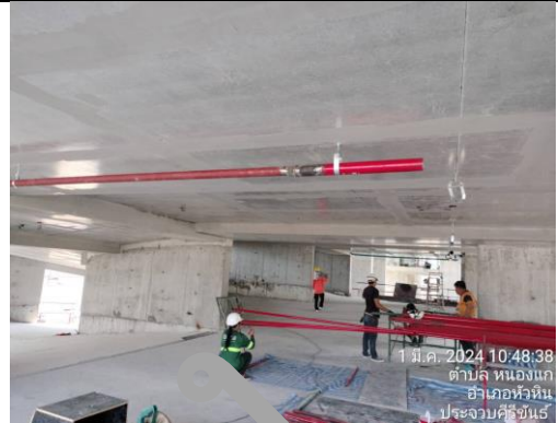
ติดตั้งท่อระบายน้ำ (ชั้นที่ 2)
