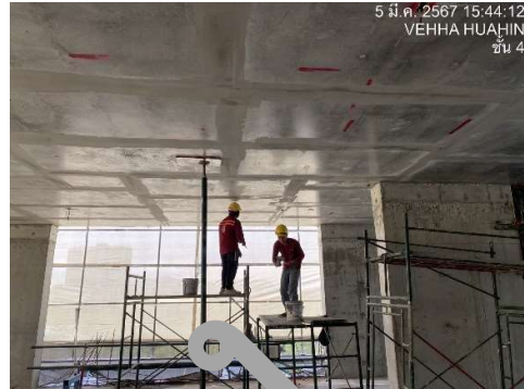
งานฉาบฉวย งานโครงสร้าง ชั้น 4
