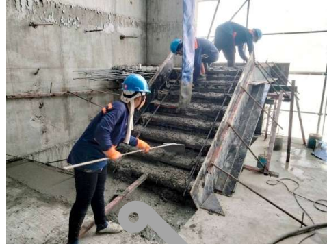
งานเทคอนกรีตบันได ST-02 ชั้น 5
