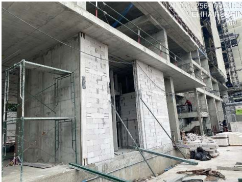
งานก่อผนัง ชั้น 1
