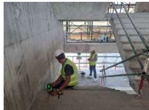
งานตรวจสอบก่อนฉาบผนังบันไดชั้น 2
