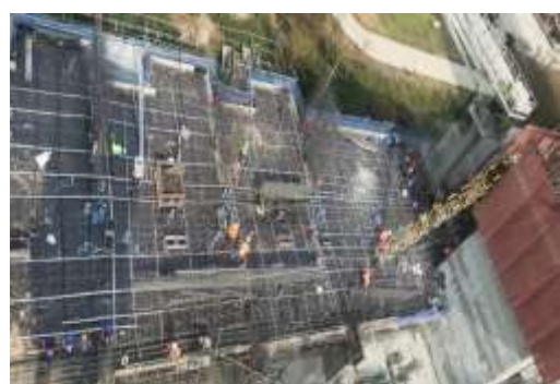
งานเก็บรายละเอียดก่อนเทพื้นชั้น 9
