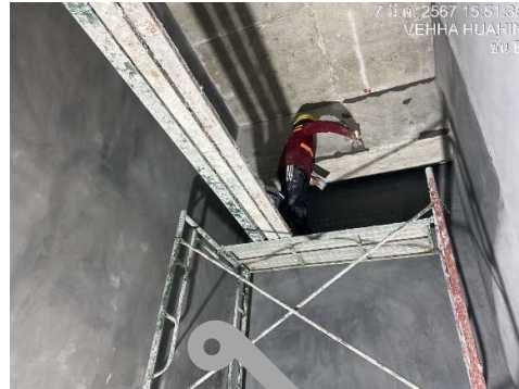
งานฉาบผิวบางลานจอดรถ ชั้น 8
