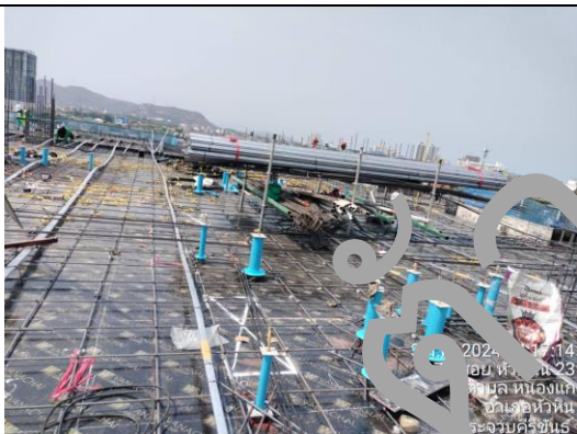
ติดตั้ง sleeve Pipe ห้องพัก (ชั้นที่ 9)
