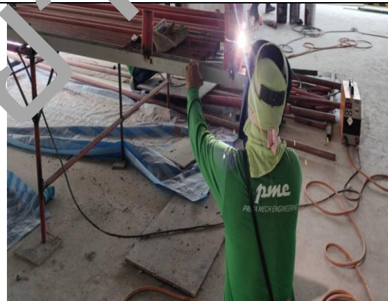
ติดตั้งท่อ SPk ชั้น 4
