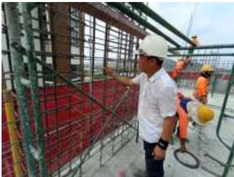
งานตรวจเหล็กเสาคอนกรีตเสาคอนกรีต
