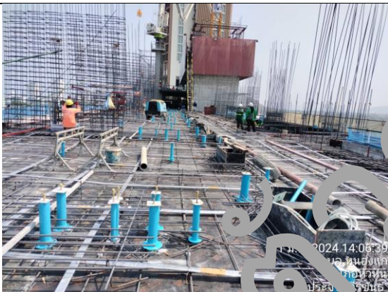
ติดตั้ง sleeve Pipe ห้องพัก ( ชั้น 10 )
