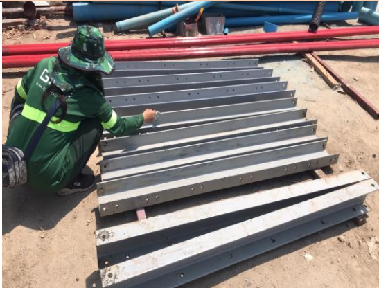
เจาะซีพอสท่อ S,W,KW,RL,ชั้น B1
