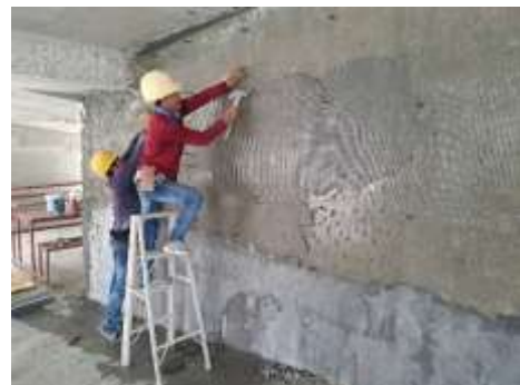
งานชั้นฉาบผนังเสาตอม่อชั้น 1
