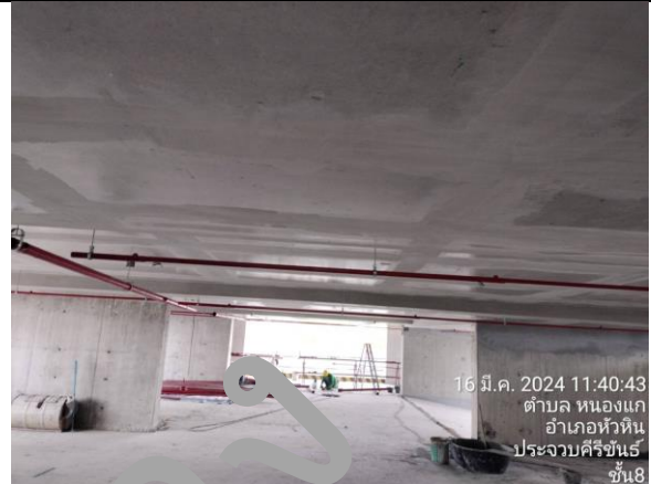
ติดตั้งท่อดับเพลิง ถานจอด ชั้น 3
