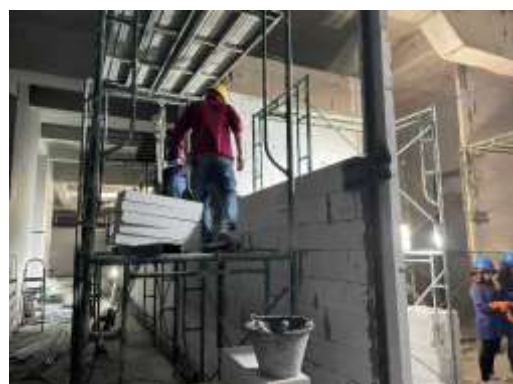
งานก่ออิฐชั้น ใต้ดิน
