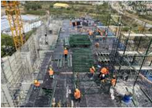
งานปูพื้นไม้ ชั้น 10
