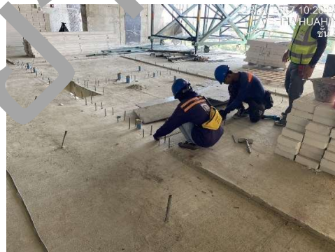
งานตรวจสอบตำแหน่งผนังก่ออิฐ ชั้น 8
