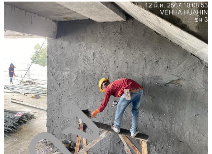
งานสทิมอาคารจอดรถ
