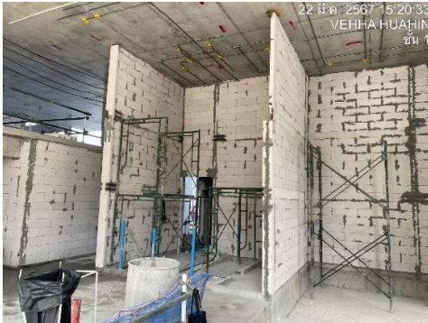
งานก่อผนัง ชั้น 1
