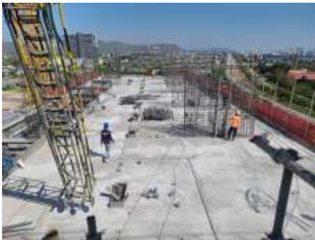
งานผูกเหล็กเสาชั้น 13
