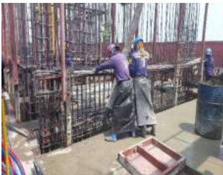
งานเทสลีฟฟอร์ม ชั้น 11-12
