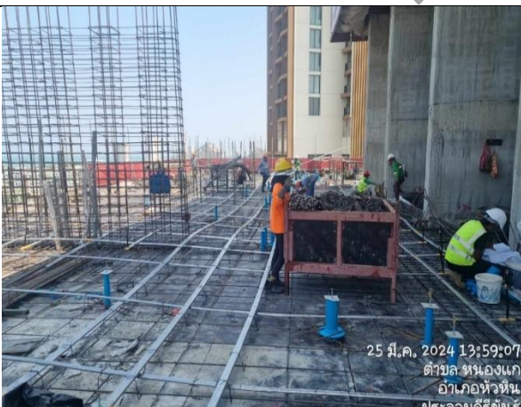
งานติดตั้ง BLOCK OUT ฝังพื้นคอนกรีต SLEEVE FOR FIXTURE FOR 13th FLOOR (PART 2)
