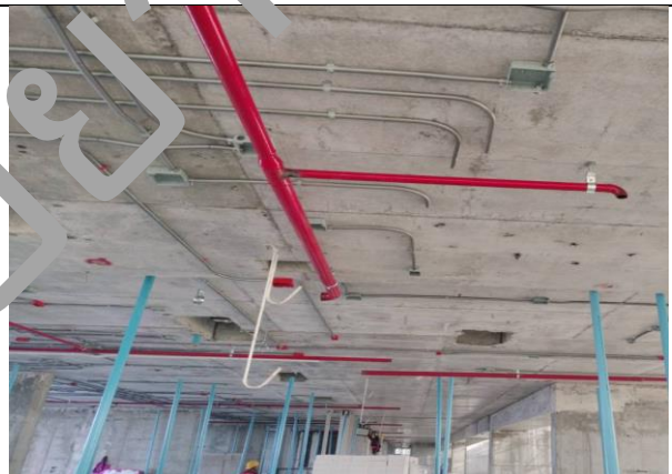
ติดตั้งท่อดับเพลิง ห้องพัก ชั้น 8
