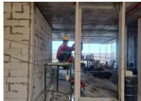
งานตรวจก่ออิฐชั้น 8
