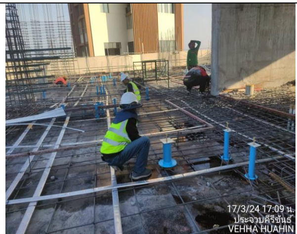
ส่งงานติดตั้ง Sleeve Pipe ห้องพัก ชั้น 12
