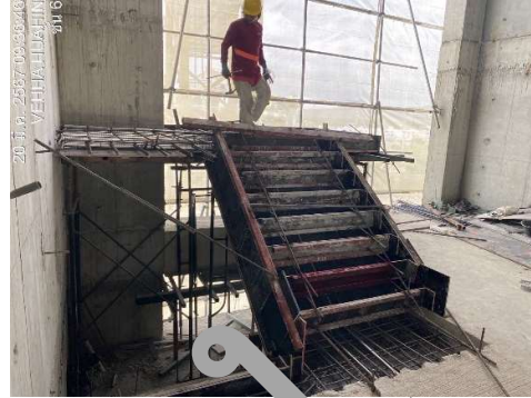
งานเหล็กบันได ST-02 ชั้น 6
