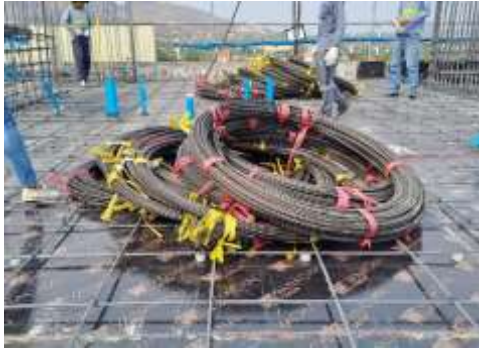
งานลงสลิ้ง ชั้น 11
