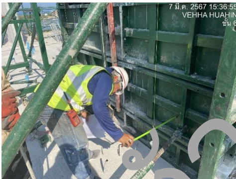
งานฉาบผิวบางลานจอดรถ ชั้น 6
