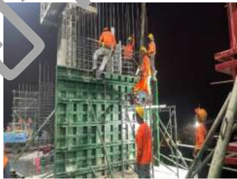
งานเทเสาชั้น 11
