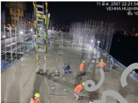
งานเทคอนกรีต ชั้น 10
