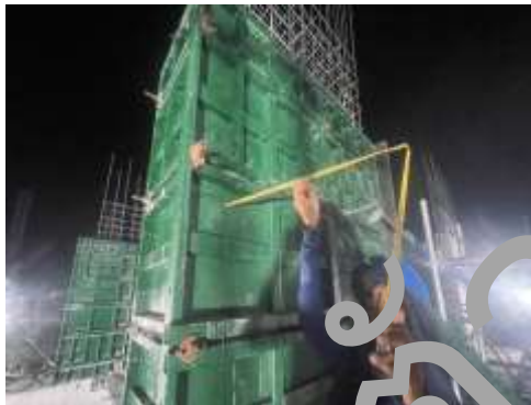
งานเสาเข็ม ชั้น 11
