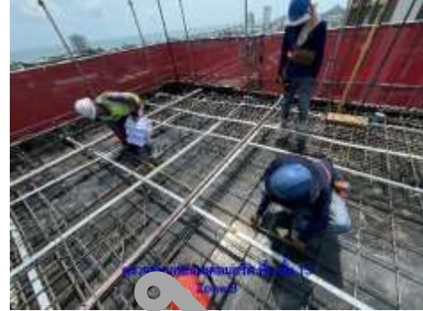
งานตรวจพื้น post ชั้น 13
