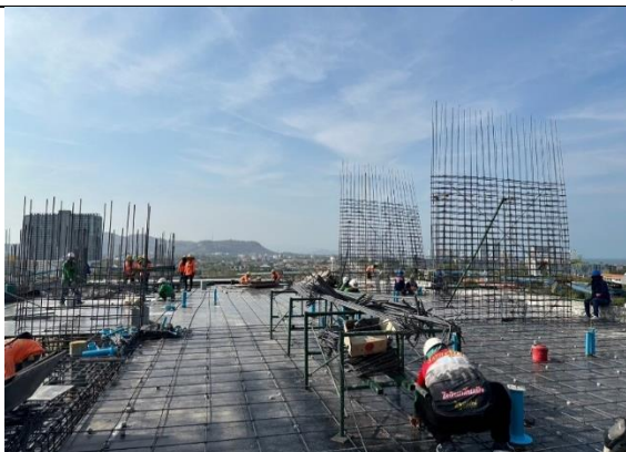
งานติดตั้ง BLOCK OUT ฝังพื้นคอนกรีต SLEEVE FOR FIXTURE 11th FLOOR (PART 1)
