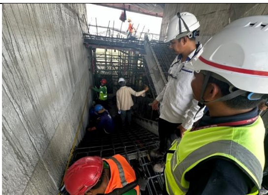
งานติดตั้งท่อ, BOX ผังพื้นที่คอนกรีตในบันไดของงานแสงสว่าง และ FIRE ALARM ( FST01 ), ( ชั้น 10 ขึ้นชั้น 11 )
