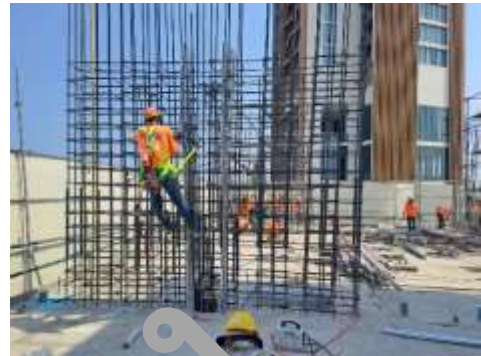
งานผูกเหล็กเสาชั้น 9
