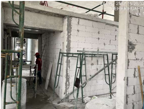
งานก่อผนัง ชั้น 1
