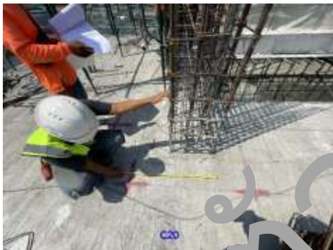
งานตรวจเหล็กเสา ชั้น 11
