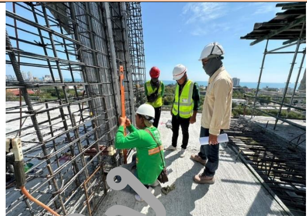
งานติดตั้ง BOX ใส่ SLEEVE FOR FIXTURE FOR 13th FLOOR (PART 1)
