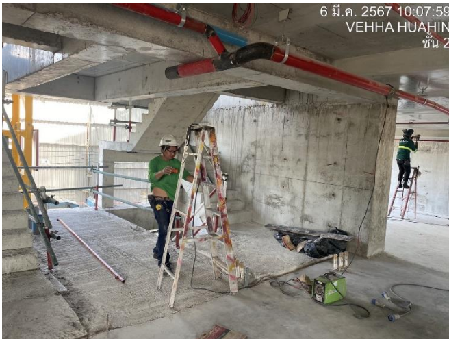
งานติดตั้งสปิงเกอร์ที่จอดรถ
