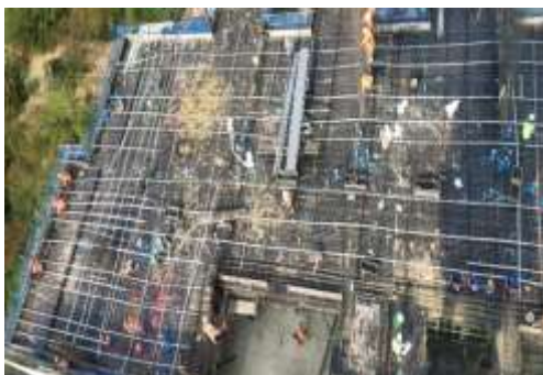
งานเก็บรายละเอียดก่อนเทพื้น ชั้น 9
