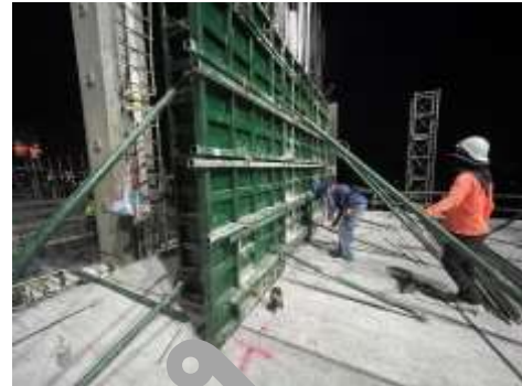
งานเทคอนกรีตเสาคอนกรีต
