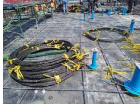
งานลงเหล็กพื้นชั้น 13
