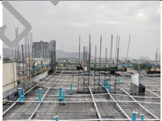
ติดตั้ง Sleeve Pipe ห้องพัก ชั้น 11
