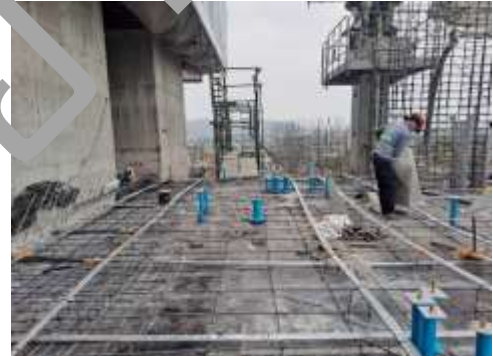
งานลงสลิ้งชั้น 12
