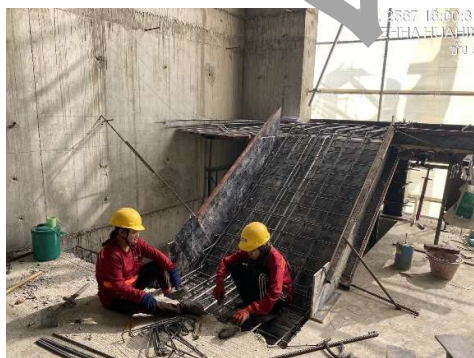
งานเหล็กเสริมบันได FST-02 ชั้น 6
