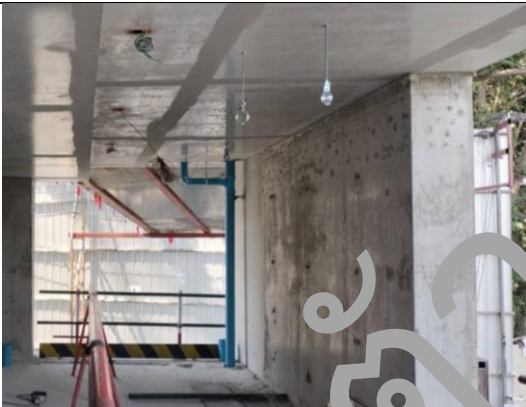
งานติดตั้งท่อ RL, ลานจอดรถ (ชั้นที่ 3)
