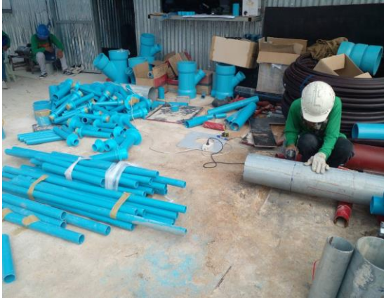
เตรียมงานติดตั้ง Sleeve Pipe ห้องพัก ชั้น 12
