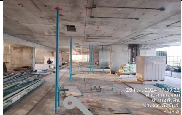
ติดตั้งกล่องไฟในผนังชั้น 8
