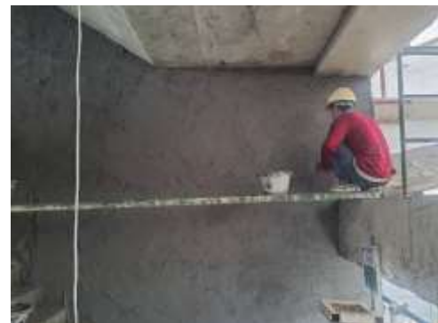
งานฉาบผนังบันไดชั้น 2
