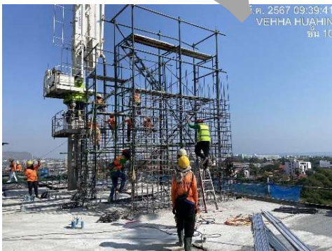
งานเหล็กเสริมเสา Zone B ชั้น 10
