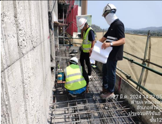
ส่งงานติดตั้ง Sleeve Pipe RL,FD,CW ชั้น 12
