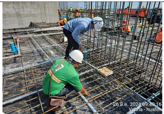
งานติดตั้ง BLOCK OUT ฝังพื้นคอนกรีต SLEEVE FOR FIXTURE FOR 13th FLOOR (PART 2)
