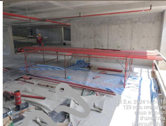
ติดตั้งท่อร้อยเคเบิล ลานจอดรถ ชั้น 3
