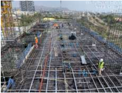
งานเตรียมเทพื้น ชั้น 10
