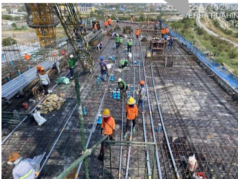
งานติดตั้งสลิงและเหล็กเสริมพื้น Zone A ชั้น 12
