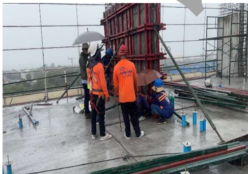
งานตรวจสอบไม้แบบและค้ำเสา ชั้น 11
