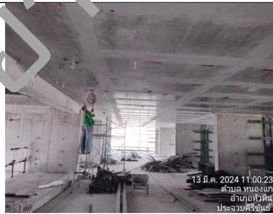
หาไลน์ติดตั้ง ซัพพอร์ท ท่อ SPk ชั้น 4
