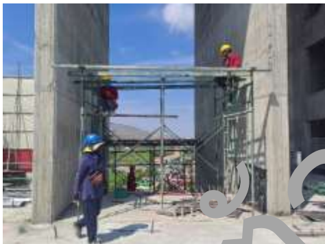
งานบันไดชั้น 13-14
