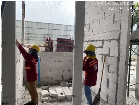
งานก่อผนังห้องน้ำ ชั้น 1
