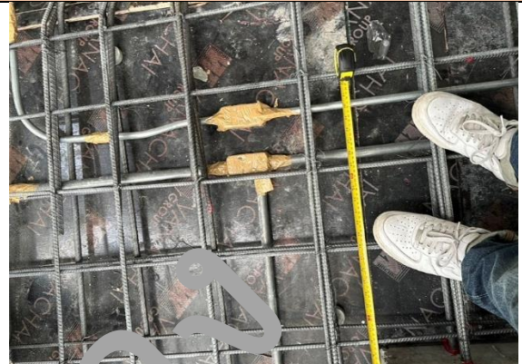
งานติดตั้งท่อ BOX ฝังท่อคอนกรีตในบันไดของงานแสงสว่างและ FIRE ALARM ( FST02 ), ( ชั้น 5 ขึ้นชั้น 6 )
