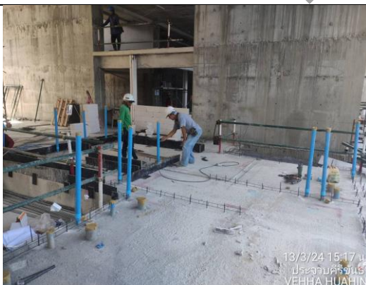
ต่อท่อห้องน้ำชั้น 1
