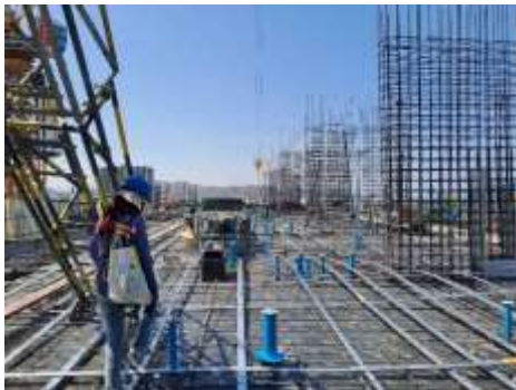
งานลงสลิ้ง ชั้น 11
