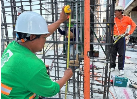
งานติดตั้งท่อ, BOX SLEEVE FOR 9th
