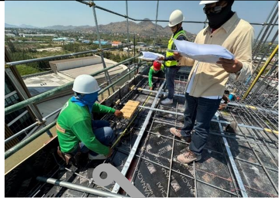
งานติดตั้ง BLOCK OUT ฝังพื้นคอนกรีต SLEEVE FOR FIXTURE 12th FLOOR ( PART 2 )
