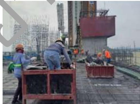
งานเตรียมลงเหล็กบนชั้น 10
