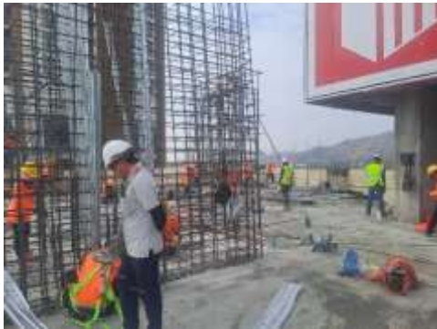
งานเตรียมเสาเข็ม ชั้น 11
