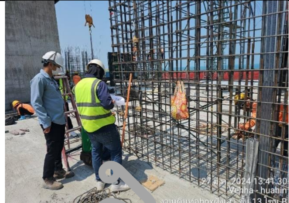
งานติดตั้งท่อ, B&CW สำหรับ SLEEVE FOR FIXTURE FOR 13th FLOOR
