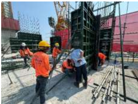
งานตรวจตั้งเสาชั้น 12
