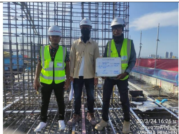
ส่งตรวจงาน Sleeve Pipe ชั้น 12 A
