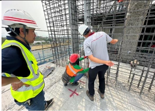
งานติดตั้งท่อ, BOX SLEEVE FOR FIXTURE FOR 10th FLOOR (PART 1)
