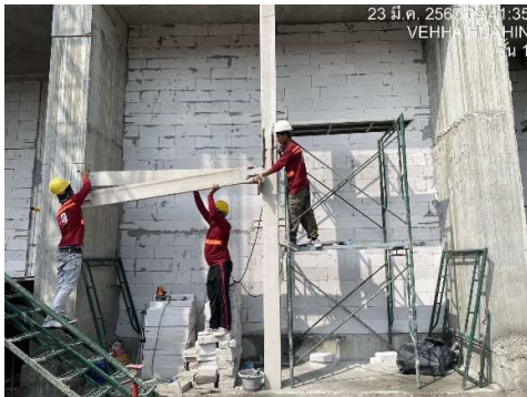
งานก่อผนัง ชั้น 1
