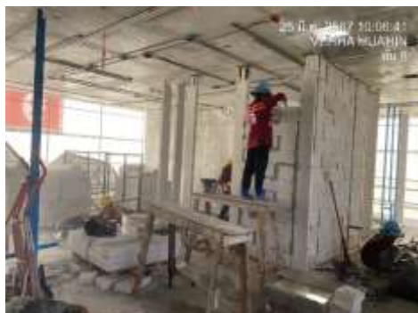
งานก่ออิฐชั้น 8
