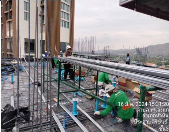
ติดตั้ง Sleeve Pipe ห้องพัก ชั้น 12
