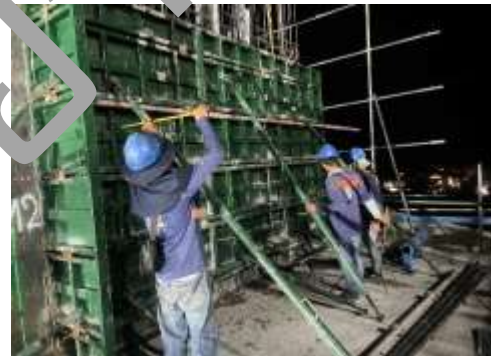
งานเทเสาคอนกรีตชั้น 12
