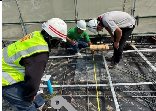
งานติดตั้ง BLOCK OUT ฝังพื้นคอนกรีต SLEEVE FOR FIXTURE FOR 11th FLOOR ( PART 2 )
