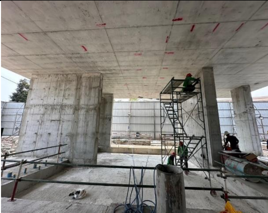
งานติดตั้งท่อเหื้อฟ้า ห้อง Kid Club ชั้น 1
