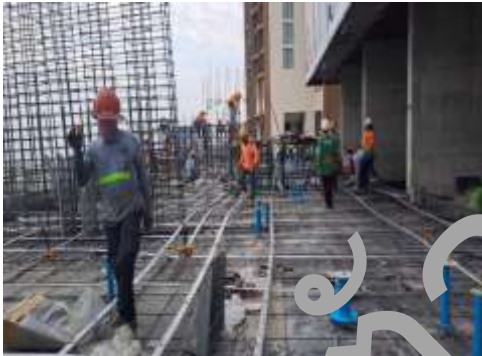
งานลงสลิ้ง ชั้น 12
