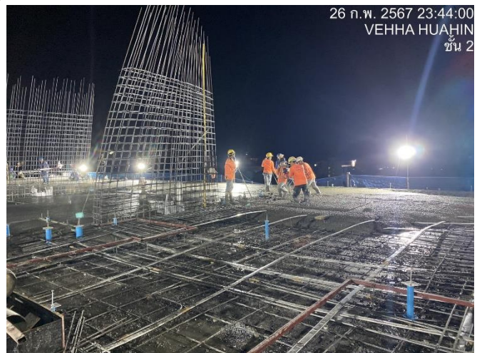
งานเทคอนกรีตพื้น Post-Tension
