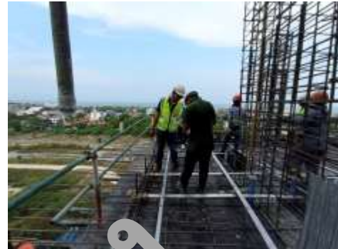
งานลงสลิ้งชั้น 13
