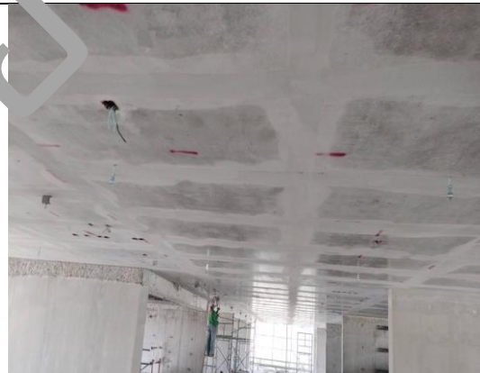
หาไลน์ ติดตั้ง ซีพอส ท่อ SPk ชั้น 4
