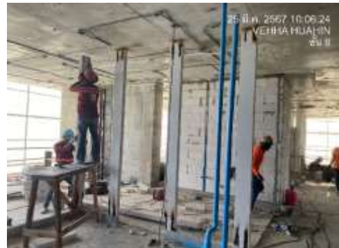
งานก่ออิฐชั้น 8
