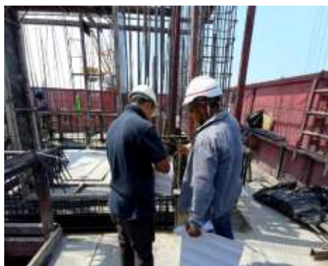
งานตรวจผนังลิฟท์ก่อนเท ชั้น 11-12
