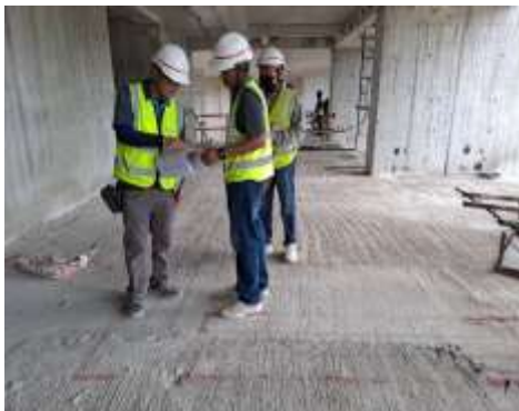
งานตรวจไลน์ก่อนเทคิบและก่ออิฐชั้น 2-3
