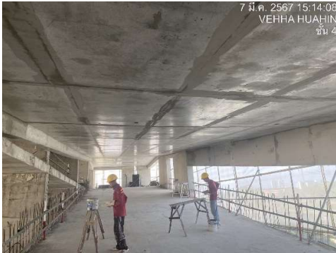
งานฉาบผิวบางลานจอดรถ ชั้น 4
