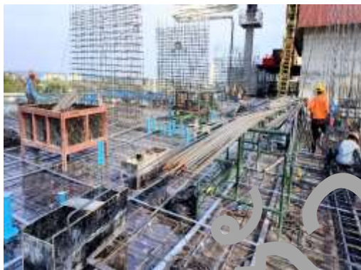
งานลงเหล็กบน ชั้น 9
