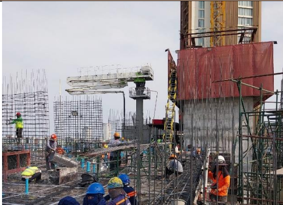
งานติดตั้งท่อ, BOX SLEEVE FOR WALL FIXTURE FOR 9th FLOOR ( PART 2 )
