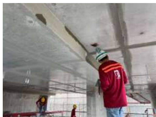
งานแต่งผิวท้องพื้นโรงรถ
