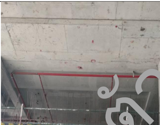
ติดตั้งท่อดับเพลิง ลานจอดรถ
