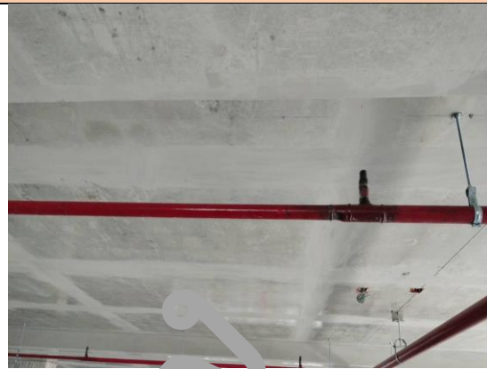
ติดตั้งท่อดับเพลิง ลานจอด ชั้น 3
