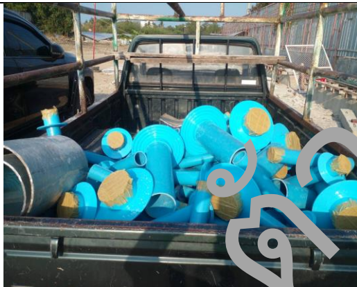
เตรียมงานติดตั้ง sleeve Pipe ห้องพัก (ชั้นที่ 11)
