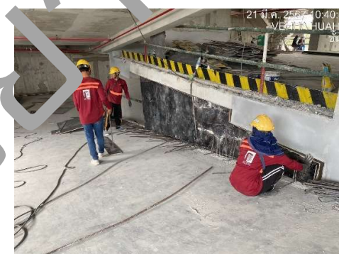
งานตรวจสอบเหล็กเสริมผนังกันตก ลานจอดรถ ชั้น 2
