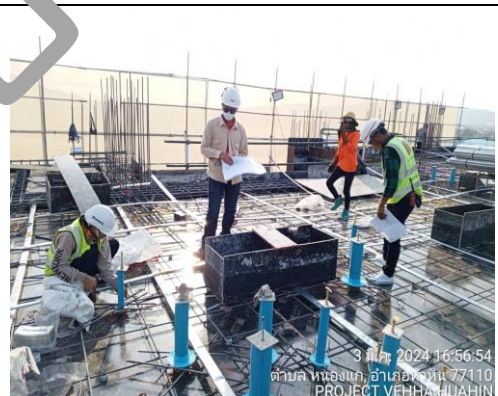
ส่งตรวจงานติดตั้ง sleeve Pipe ห้องพัก (ชั้นที่ 9)
