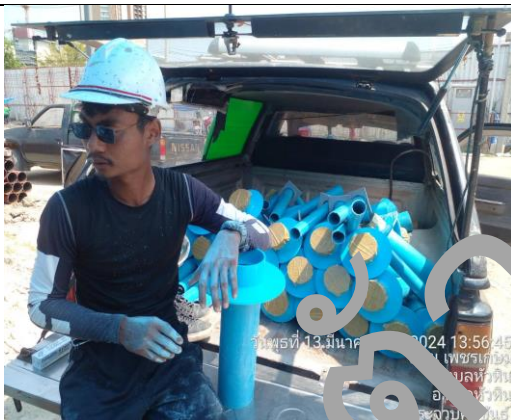
เตรียมงานติดตั้ง sleeve Pipe ห้องที่ 11)
