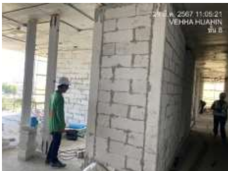
งานตรวจก่ออิฐชั้น 8
