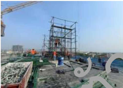
งานเตรียมลงเหล็กบนชั้น 10
