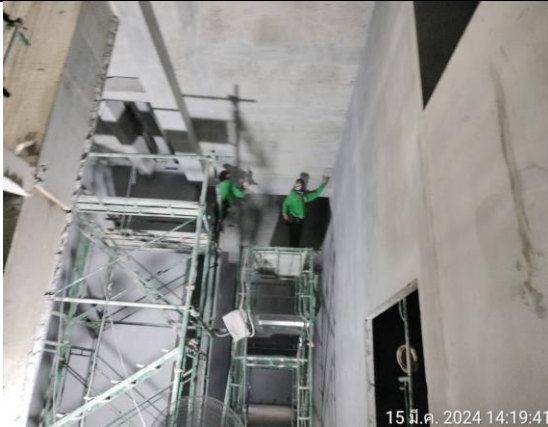
เจาะช่องพอสท่อ S,W,KW,RL,ชั้น B1
