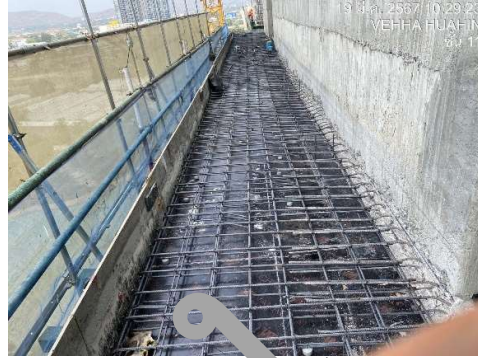
งานเหล็กริบบิ้นพื้น ชั้น 11
