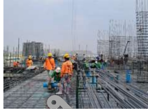
งานลงสลิ้งชั้น 11
