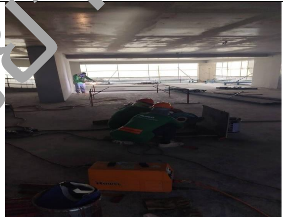
ประกอบท่อดับเพลิง ชั้น 4*
