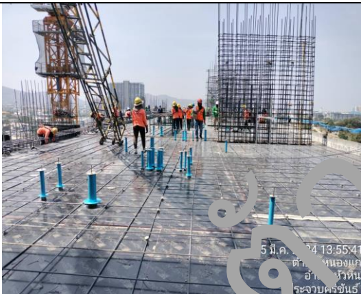
งานติดตั้ง sleeve Pipe ห้องพัก (ชั้น 11)
