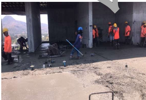
งานเทคอนกรีตพื้น ชั้น 12
