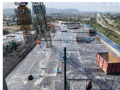
งานไม้แบบและเหล็กเสริมพื้น ชั้น 12
