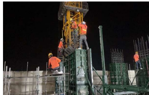
งานเทคอนกรีตเสา ชั้น 9
