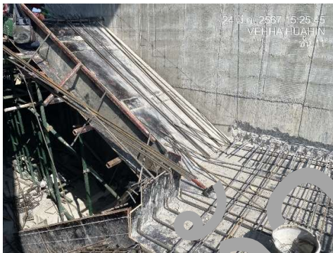
งานบันได FST-01 ชั้น 12-13
