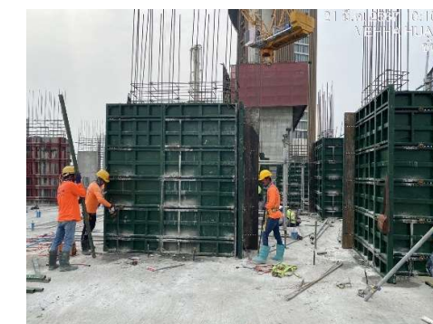
งานรื้อไม้แบบเสา ชั้น 11
