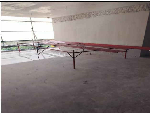
ประกอบท่อดับเพลิง ลานจอด ชั้น 4
