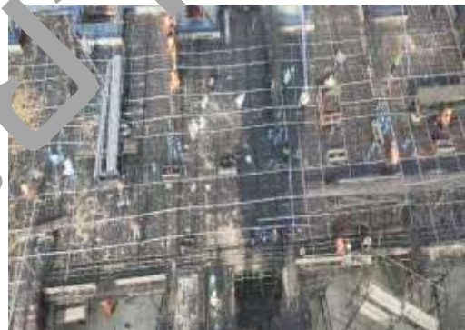
งานลงเหล็กบนชั้น 9
