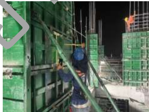
งานเสาเข็ม ชั้น 11
