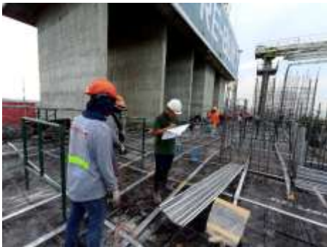
งานลงสลิ้ง ชั้น 13
