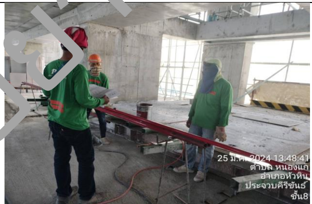
ประกอบท่อดับเพลิง ห้องพัก ชั้น 8
