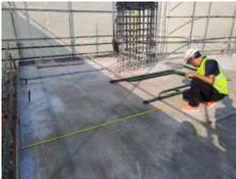
งานตรวจระยะชั้น ชั้น 9
