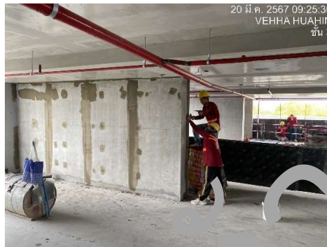
งานฉาบผิวผนังโครงสร้าง คอนกรีต ชั้น 3
