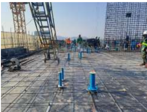
งานปูพื้นไม้ ชั้น 9
