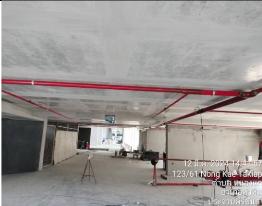
ติดตั้งท่อดับเพลิง ลานจอด ชั้น 1
