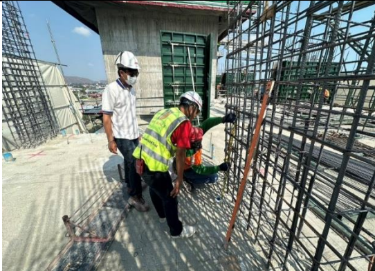
งานติดตั้งท่อ, BOX SLEEVE FOR WALL FIXTURE FOR 9th FLOOR ( PART 2 )
