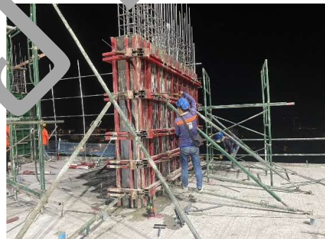
งานเทคอนกรีตเสา ชั้น 11
