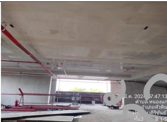
ติดตั้งท่อดับเพลิง ลานจอดรถ ชั้น 3
