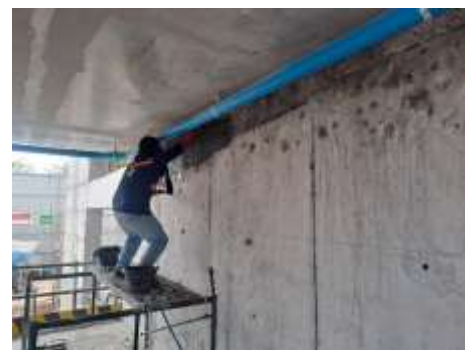
งานชั้นฉาบผนังเสาถาวรจอดชั้น 2
