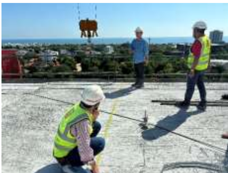
งานตรวจสอบไลน์พื้นชั้น 13
