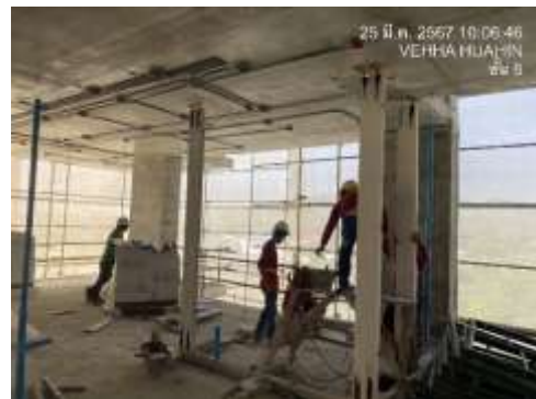
งานก่ออิฐชั้น 8
