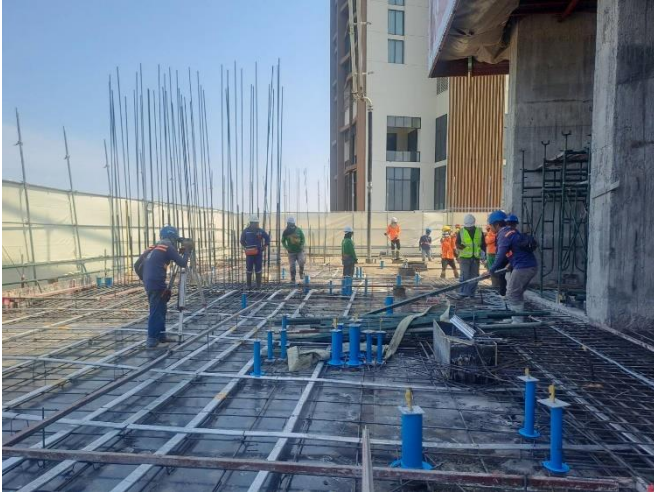
งานวางสลึง Post-Tension
