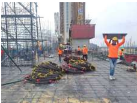
งานลงสลิ้ง ชั้น 10
