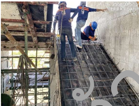
งานเหล็กเสริมบันได ST-01 ชั้น 9
