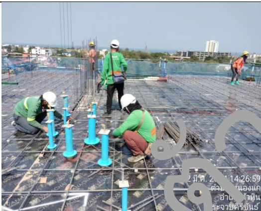
ติดตั้ง sleeve Pipe ห้องพัก (ชั้นที่ 1)
