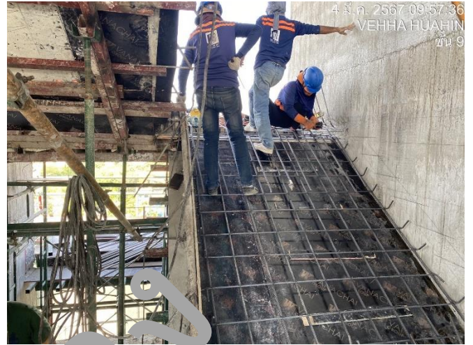
งานโครงสร้างบันได
