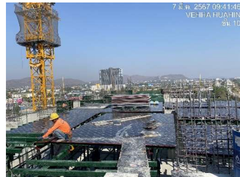
งานไม้แบบพื้น Zone A ชั้น 10
