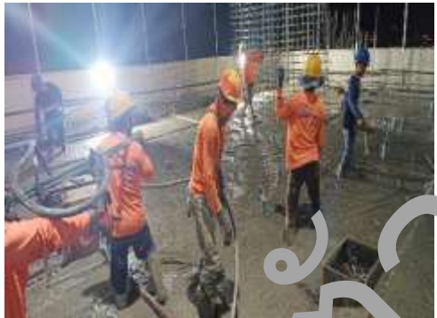
งานเทคอนกรีต ชั้น 11
