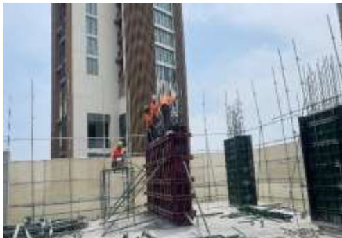
งานเทเสา ชั้น 9
