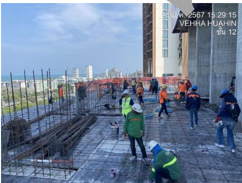
งานไม้แบบและเหล็กเสริมพื้น Zone B ชั้น 13
