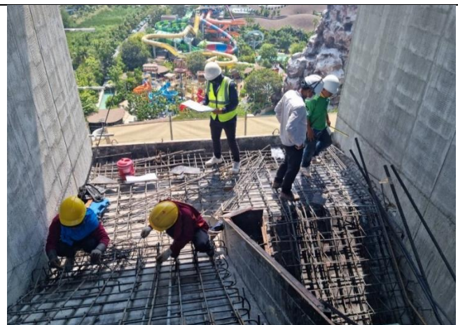
งานติดตั้งท่อ, BOX ฝังพื้นคอนกรีตในบันไดของงานแสงสว่างและ FIRE ALARM ( FST01 ), ( ชั้น 12 ขึ้นชั้น 13 )
