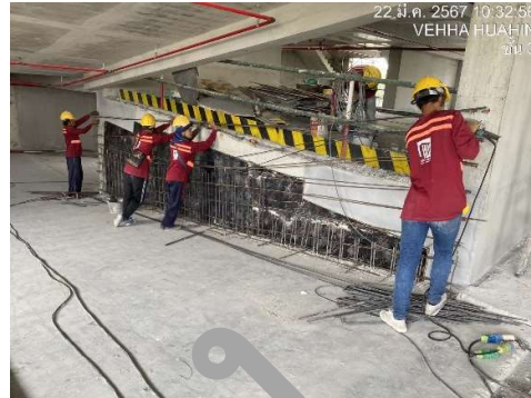
งานเหล็กเสริมและจัดวางงานจอตลอด ชั้น 2
