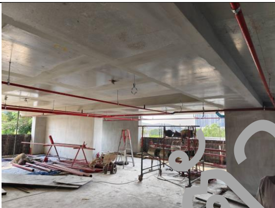
ติดตั้งท่อดับเพลิง ลานจอดรถ
