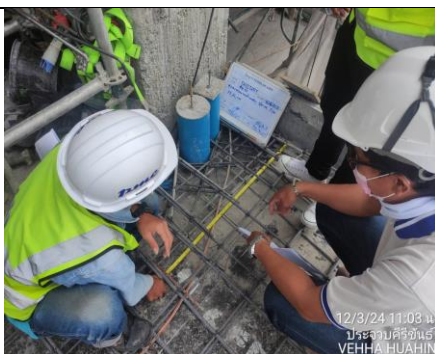
ทำงานติดตั้ง Sleeve Pipe FD,RL,CW ชั้น 10
