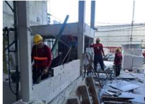
งานก่ออิฐชั้นล่าง
