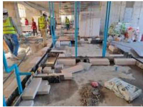
งานก่ออิฐชั้น
