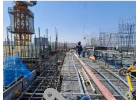
งานลงสลิ้งชั้น 11
