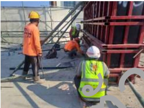
งานตรวจคานเสา ชั้น 9
