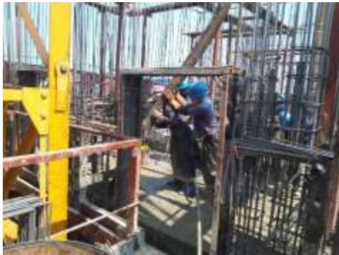
งานเทสลีฟฟอร์ม ชั้น 13-14
