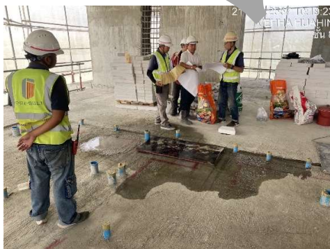
งานตรวจตำแหน่งผนังก่ออิฐ ชั้น 8
