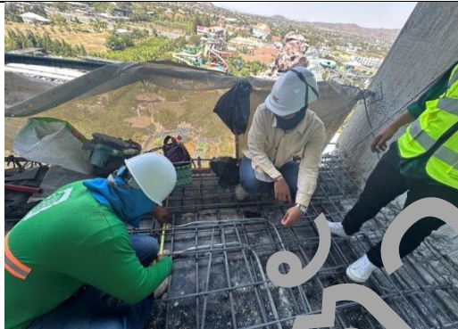
งานติดตั้งท่อ, BOX ฝังพื้นคอนกรีต ฝังไฟ ของ ระบบแสง สว่างและ FIRE ALARM ( FST01 ), ( ช่าง ชื่นชื่น 12 )
