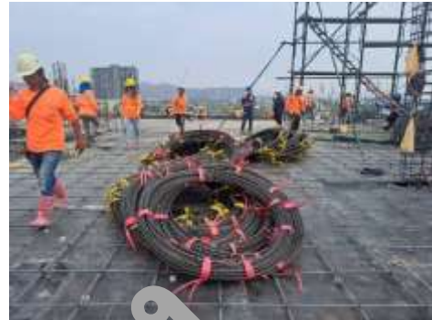
งานลงเหล็กชั้น 10
