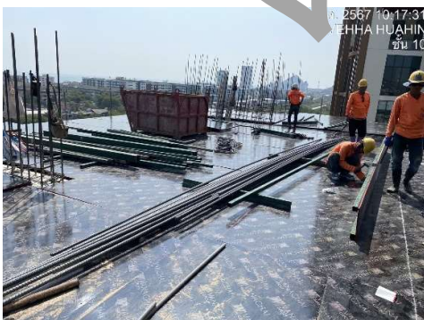
งานไม้แบบพื้น Post tension Zone B ชั้น 10
