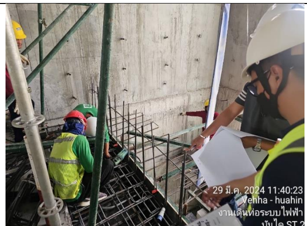
งานติดตั้งท่อ, BOX ผังพื้นที่คอนกรีตชั้น 7 ของงาน POWER AND COMMUNICATION SYSTEM FOR 6th FLOOR PLAN (PART 1)
