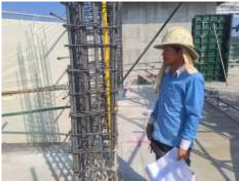
งานตรวจเหล็ก ชั้น 9
