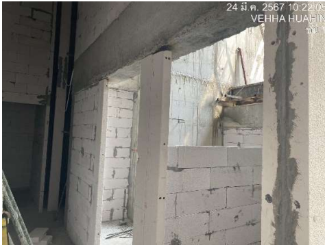
งานก่อผนัง ชั้น 1
