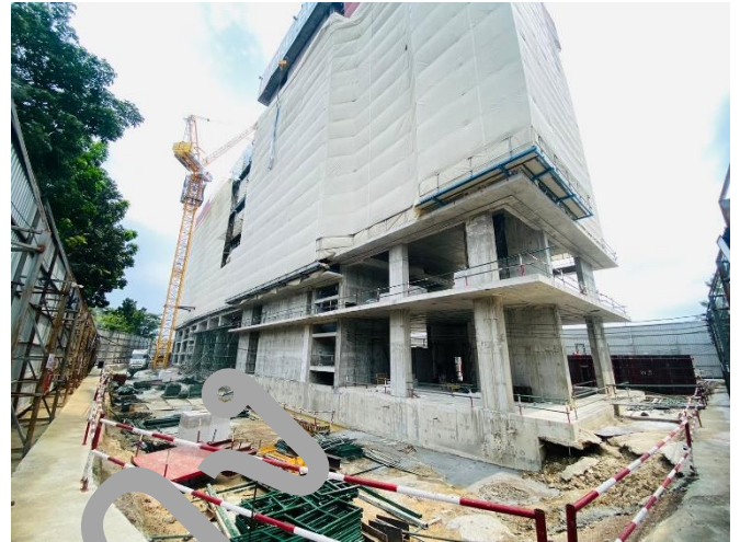
ภาพรวมงานโครงสร้าง
