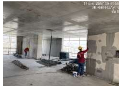
งานฉาบผนังเสาฉาบฉาบจอดรตชั้น 2
