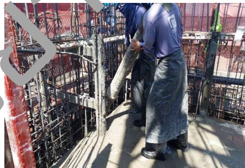
งานเทคอนกรีต Slipform ชั้น 11-12
