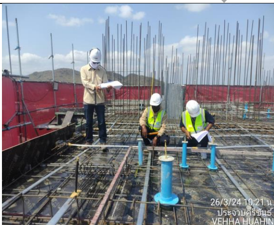
ส่งงานติดตั้ง Sleeve Pipe ห้องพัก ชั้น 12 A
