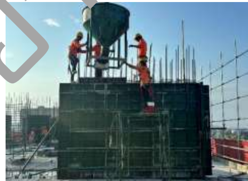
งานเทเสาคอนกรีตชั้น 13
