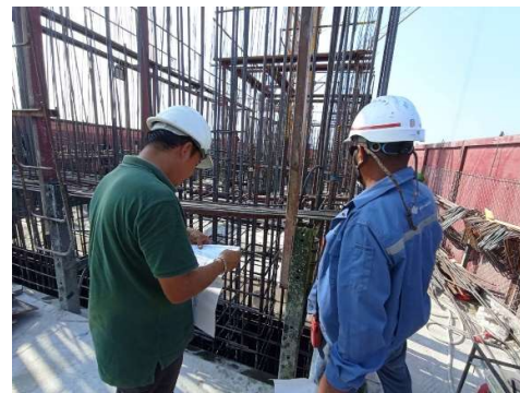
งานตรวจสอบเหล็กเสริมผนังลิฟต์ก่อนเทคอนกรีต ชั้น 10
