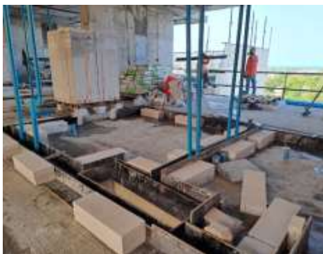
งานก่ออิฐชั้น
