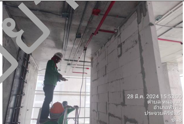
เชื่อมท่อดับเพลิง ห้องพัก ชั้น 8
