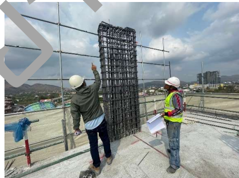
งานตรวจสอบเหล็กเสริมเสา ชั้น 11
