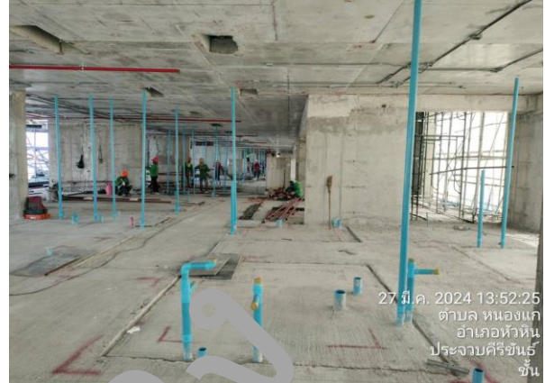
เดินท่อ W,V,KW ในผนังชั้น 8
