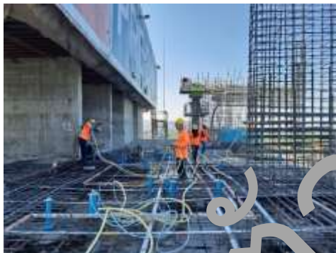
งานลงสลิ้ง ชั้น 12
