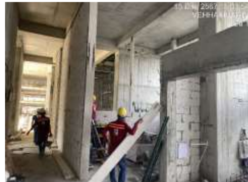
งานก่ออิฐชั้นล่าง
