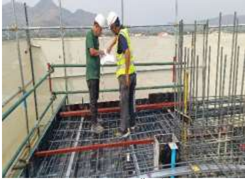
งานเตรียมเทพื้น ชั้น 11
