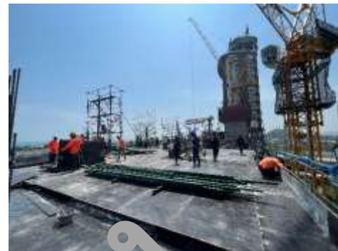
งานลงเหล็กล่างชั้น 11
