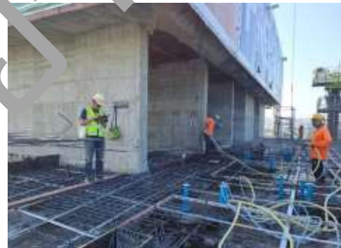
งานลงสลิ้งชั้น 12
